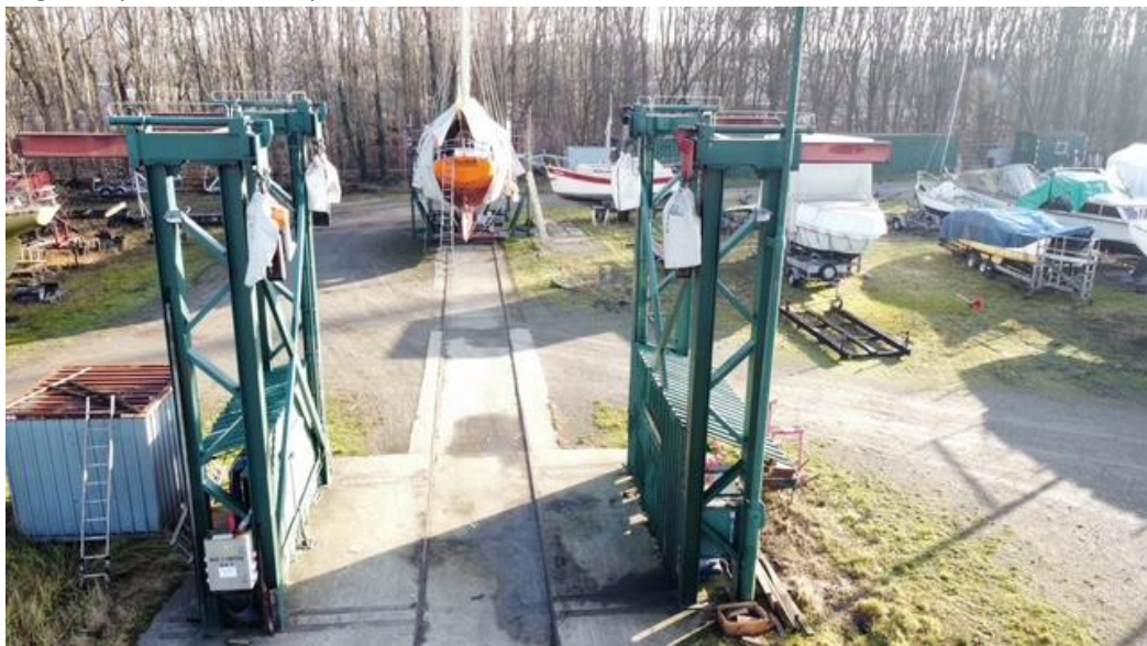
De huidige portiek op terrein Noord, gebouwd naar het idee van Jos Liekens.
